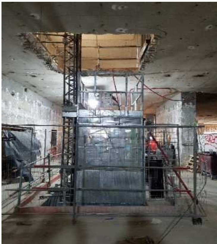
47 Création de trémie provisoires pour monte-charge-
