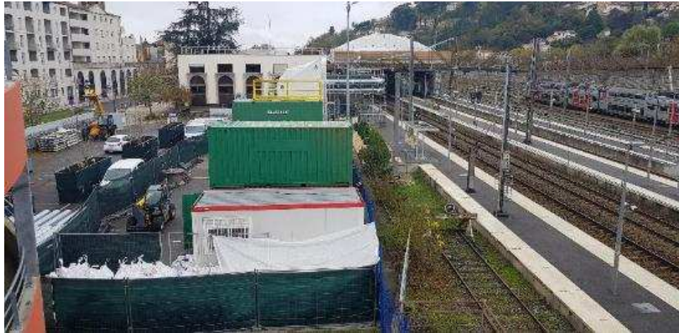
Installation technique « plomb »
