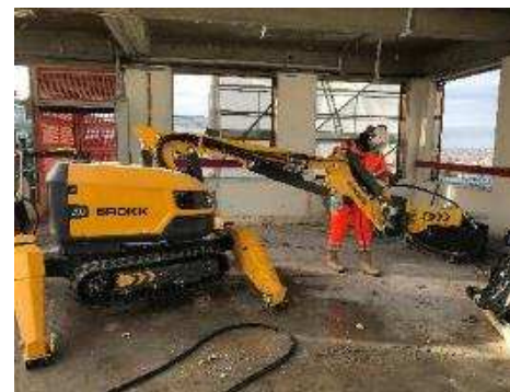
Réaménagement des volumes intérieurs
