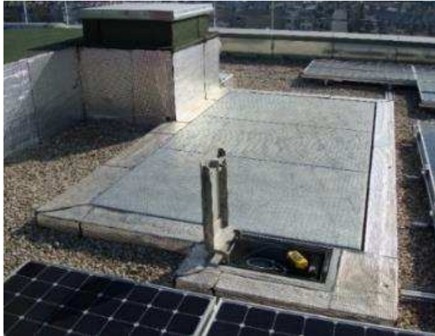
Trappe à ouverture hydraulique, avec garde-corps pour accès en toiture
