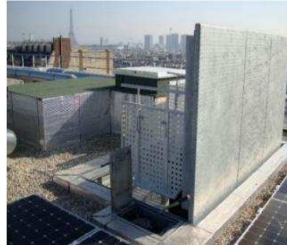
Trappe à ouverture hydraulique, avec garde-corps pour accès en toiture
