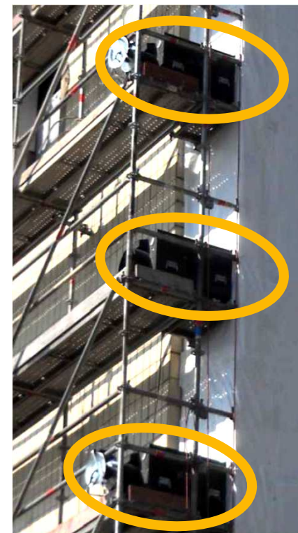
Extracteurs sur échafaudages
