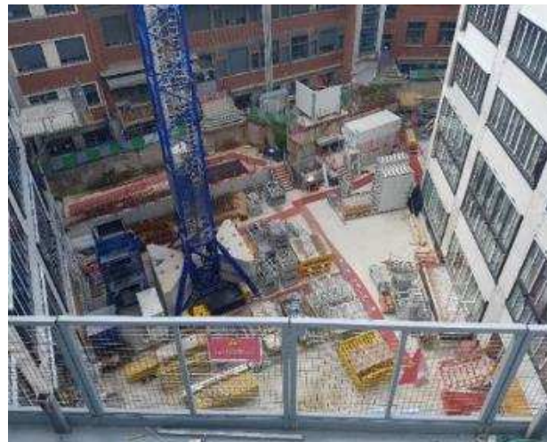
Stockage au sol et sur plateforme
