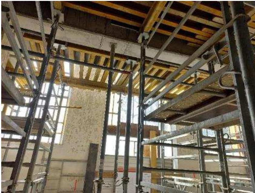
Etalement provisoire
