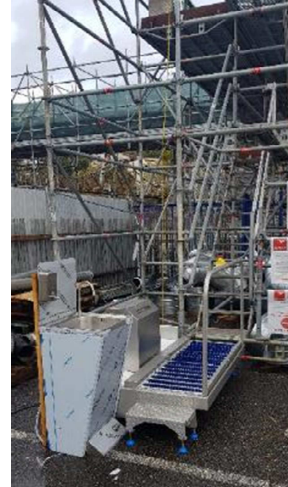
Aménagement sortie zone travaux
