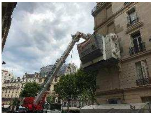
9 Dépollution de bâtiment / traitement de façade
