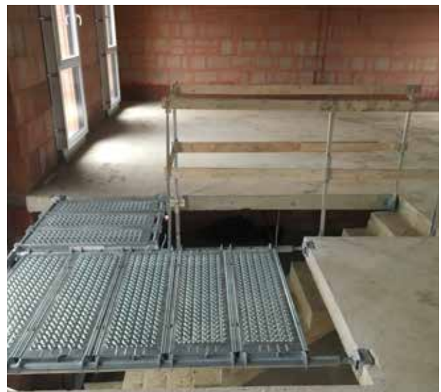
Trémie positionnée contre mur avec présence d'un escalier définitif. Photo Maison Claire
