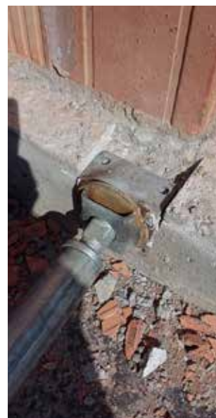
Vérin support de platelage (prévoir un décaissement sous vérin d'environ 5 mm)
