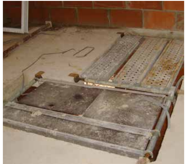
Trémie positionnée contre un mur. Absence d'escalier. Photo Altrad
