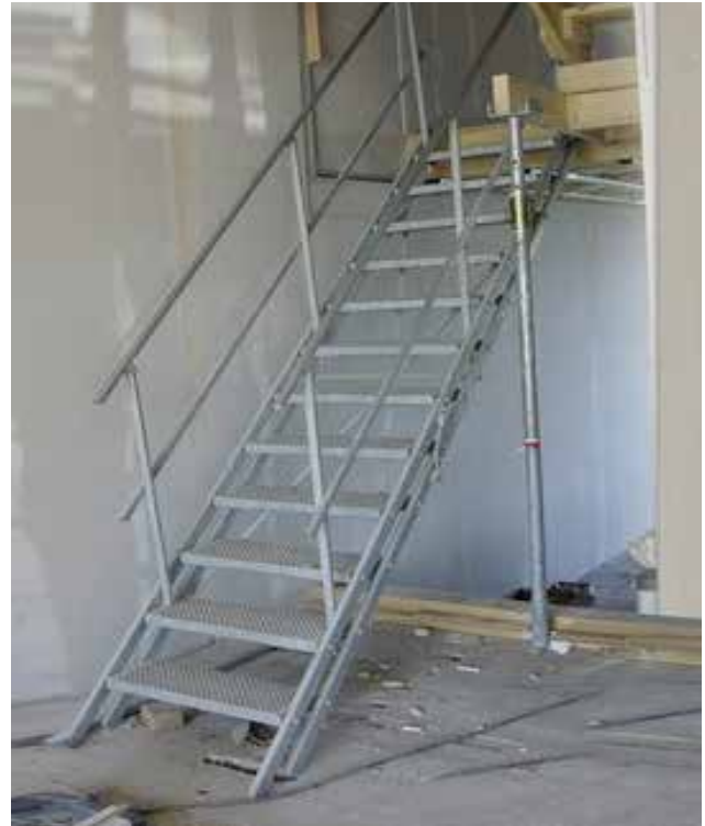
Escalier provisoire modulaire
