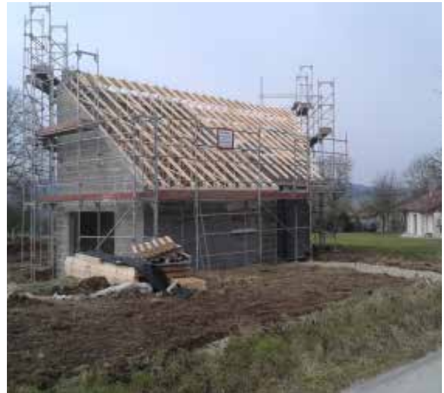
Privilégier les échafaudages MDS (Montage-Démontage en sécurité)
