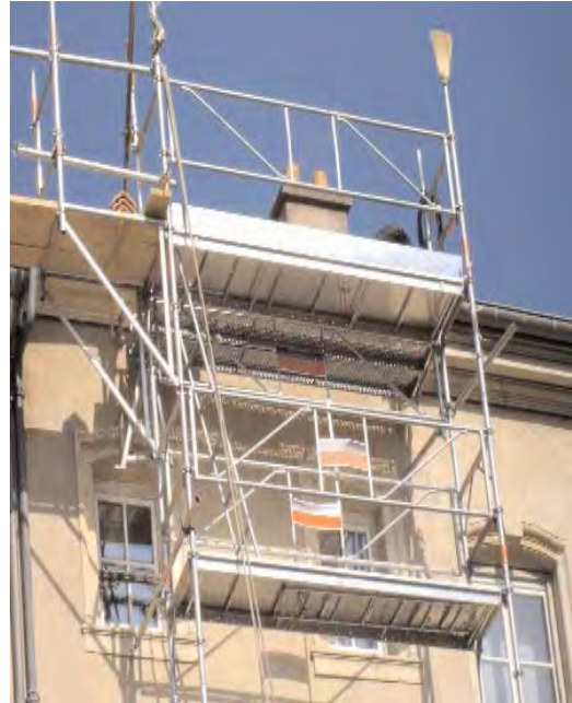
Échafaudage de pied
