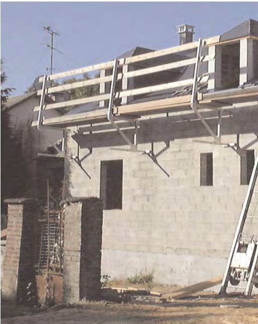
Échafaudage sur consoles
