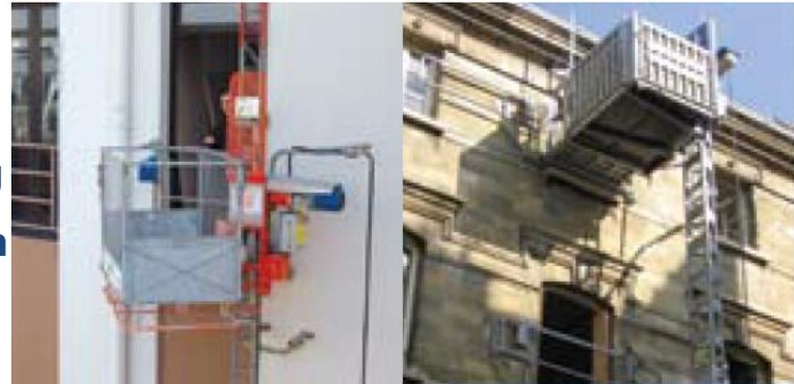
Monte-matériaux - Charge utile 500 kg à caisse pivotante.
