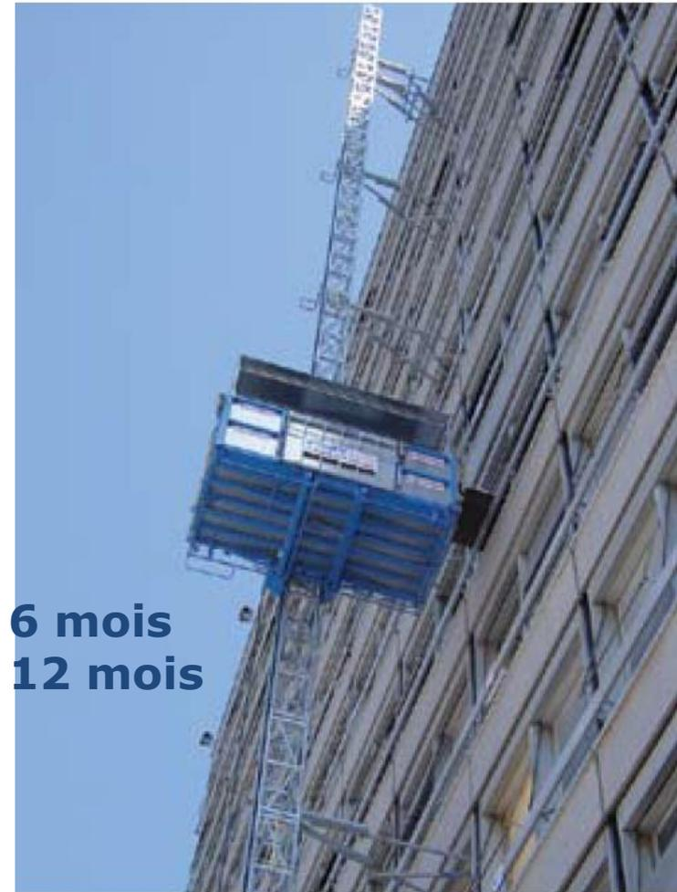
Plateforme de transport mono-mât - charge utile 1500 kg - chargement sur 2 côtés.
