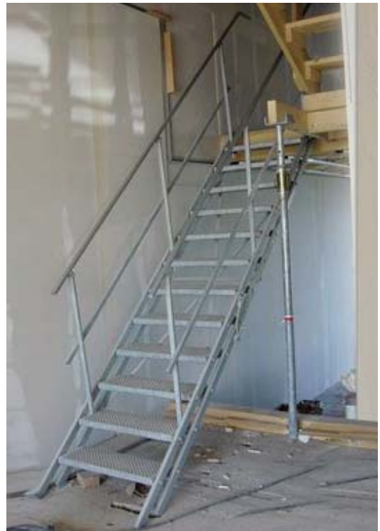
Escalier provisoire modulaire
