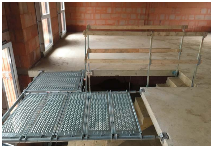
Trémie positionnée contre mur avec présence d'un escalier définitif. Photo Maison Claire
