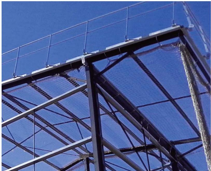
À défaut, lever et monter les garde-corps provisoires avec la charpente. Prévoir des systèmes de crochet agryss (ou accro-pattes) laissé en place pour la pose de garde-corps en phase exploitation ;
