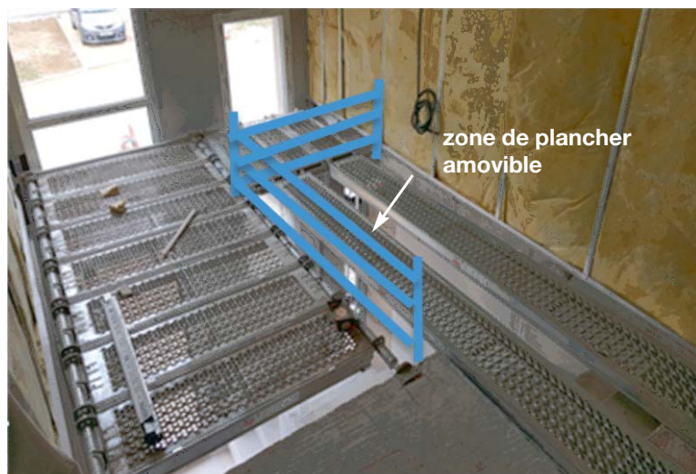
Trémie positionnée contre mur avec présence d'un escalier définitif
