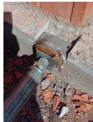
Vérin support de platelage (prévoir un décaissement sous vérin d'environ 5 mm)
