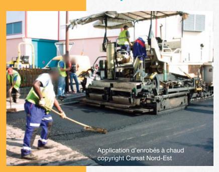
L'ouvrier routier participe à la réalisation d'un revêtement continu imperméable à base d'enrobés bitumineux à chaud. Ce produit sert principalement d'assise et de revêtement pour les chaussées et les trottoirs. On parle de travaux de
